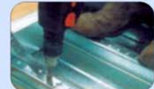
Step 7 Fix steel edge form
